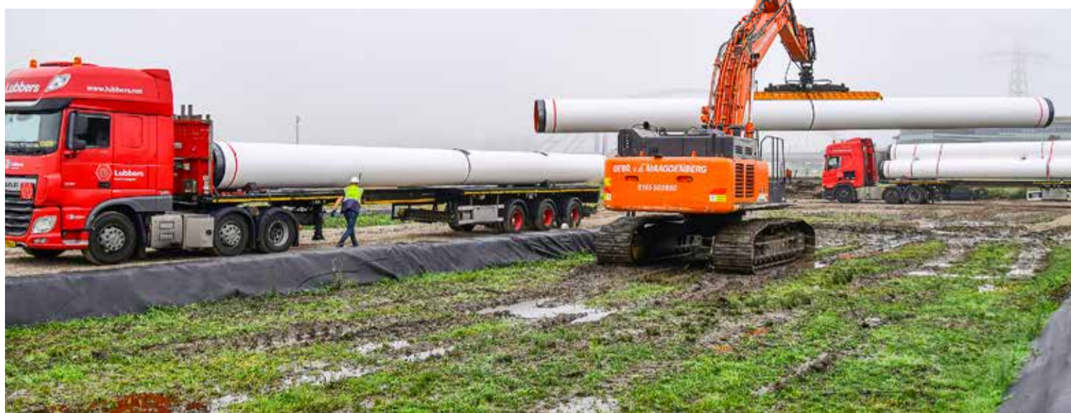
De buizen voor het ondergrondse Porthos-traject door de haven zijn gearriveerd. In totaal gaat het om 2150 buisdelen van elk 18 meter.
