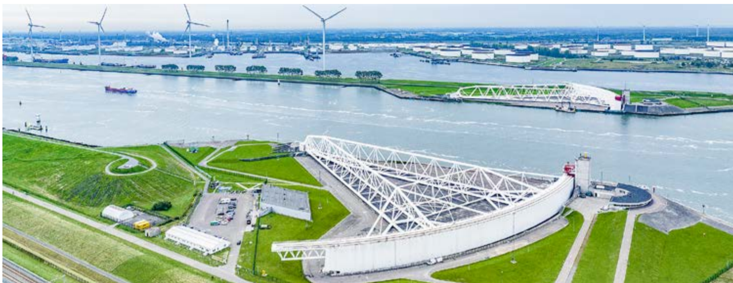
De Maeslantkering beschermt, samen met de Hartelkering en dijken, de binnendijkse gebieden tegen overstromingen.
